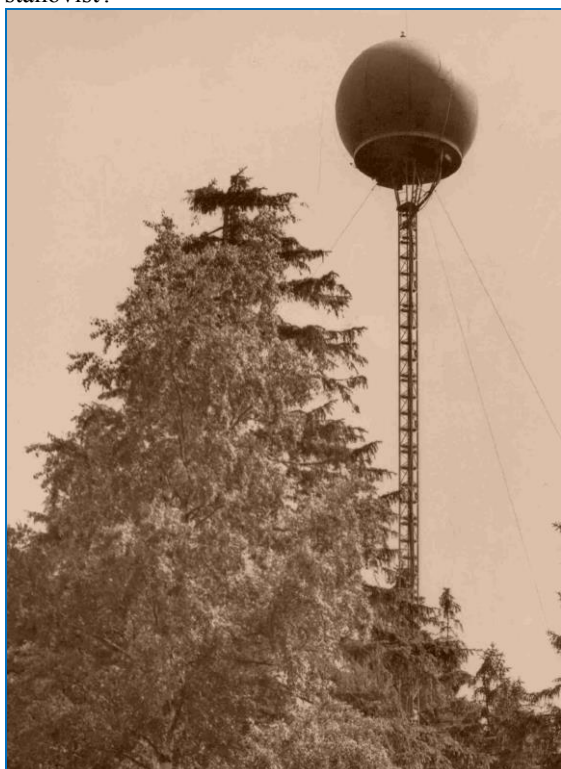
Obr.4: RAMONA- anténní jednotka na stožáru 25 m
